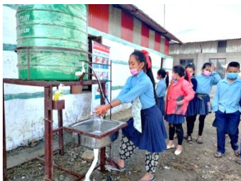
Die neuen Wassertanks lassen sich über ein Pedal mit dem Fuß bedienen
